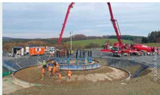
Anlag 1: Mëtt November gouf d'Fundament aus Beton gegoss Eolienne 1 : coulage du béton de la fondation mi-novembre
