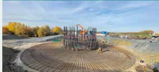
Anlag 1 : Armierung vum Fundament Eolienne 1 : ferrailage de la fondation
