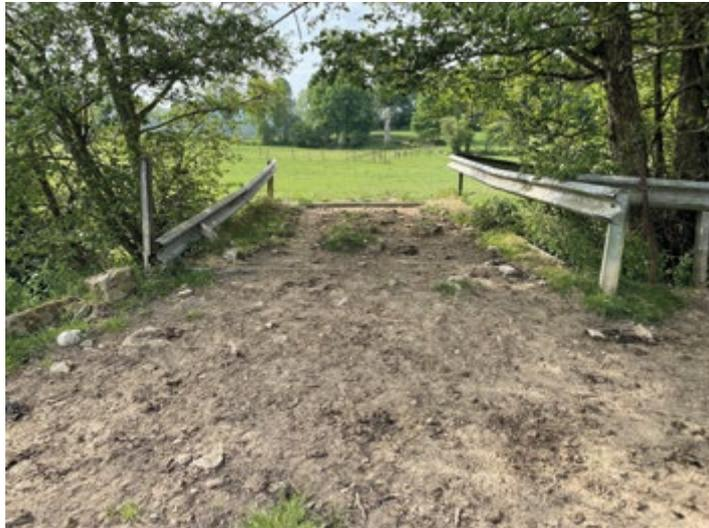
Eine Viehbrücke in einer Stahl-Holzkonstruktion ermöglicht den Übergang des Viehs auf die andere Uferseite. Das Holz für den Bau beider Brücken stammt aus den Wäldern des Forstreviers Beckerich.
