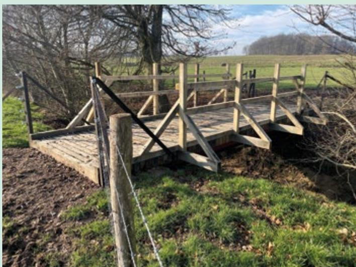
Une passerelle à bétail en acier-bois permettant le passage du bétail de part et d'autre de la rivière. Le bois pour la construction des deux ponts provient des forêts de triage de Beckerich.
